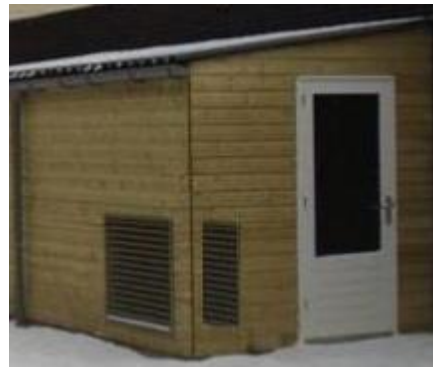
Figuur 5.3 Buitendeel in gevel fietsenschuur
