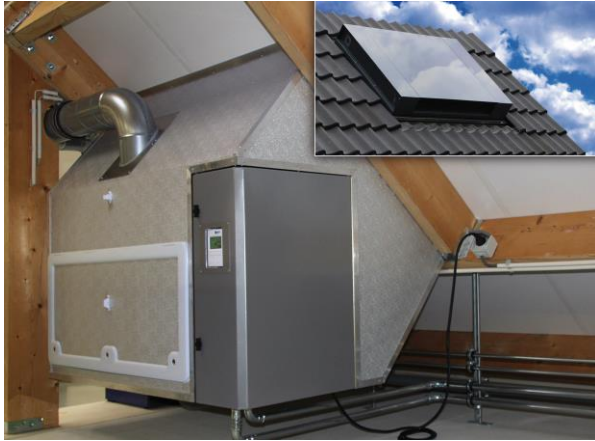
Figuur 5.6 Warmtepomp, boilervat en buitendeel in één gecombineerde zolderunit
